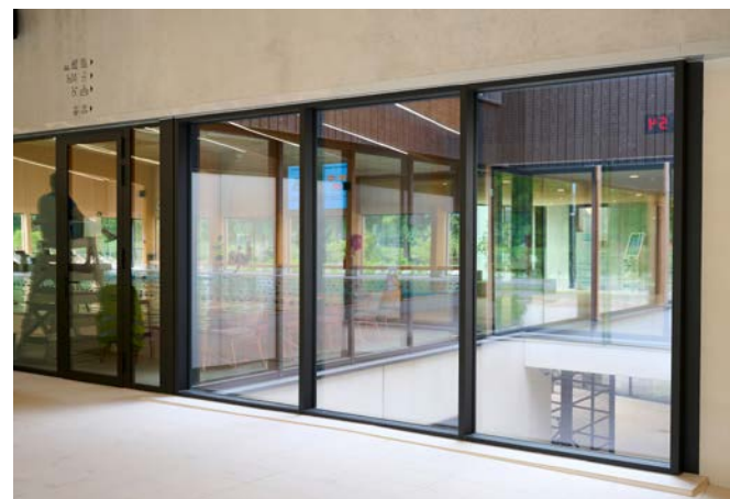
Het nieuwbouwwolume met grote glaspartijen en gebrand hout in de gevel werd tegen de bestaande sporthal in beton en met kleine raamopeningen gebouwd.
