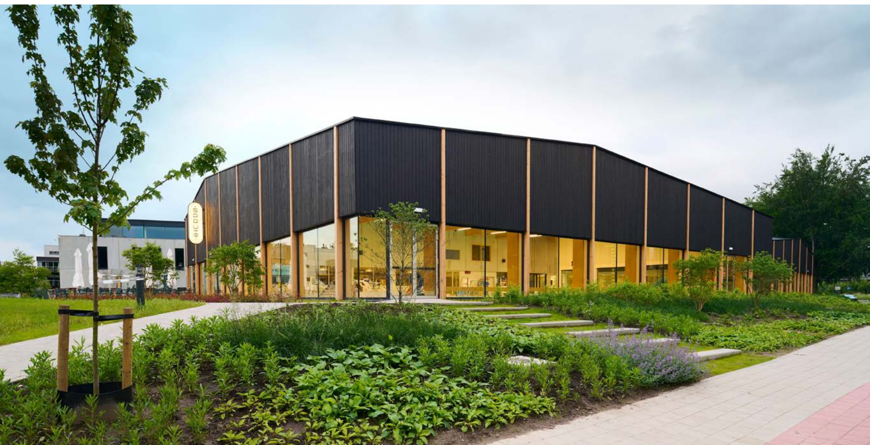
Het nieuwbouwwolume met grote glaspartijen en gebrand hout in de gevel werd tegen de bestaande sporthal in beton en met kleine raamopeningen gebouwd.
