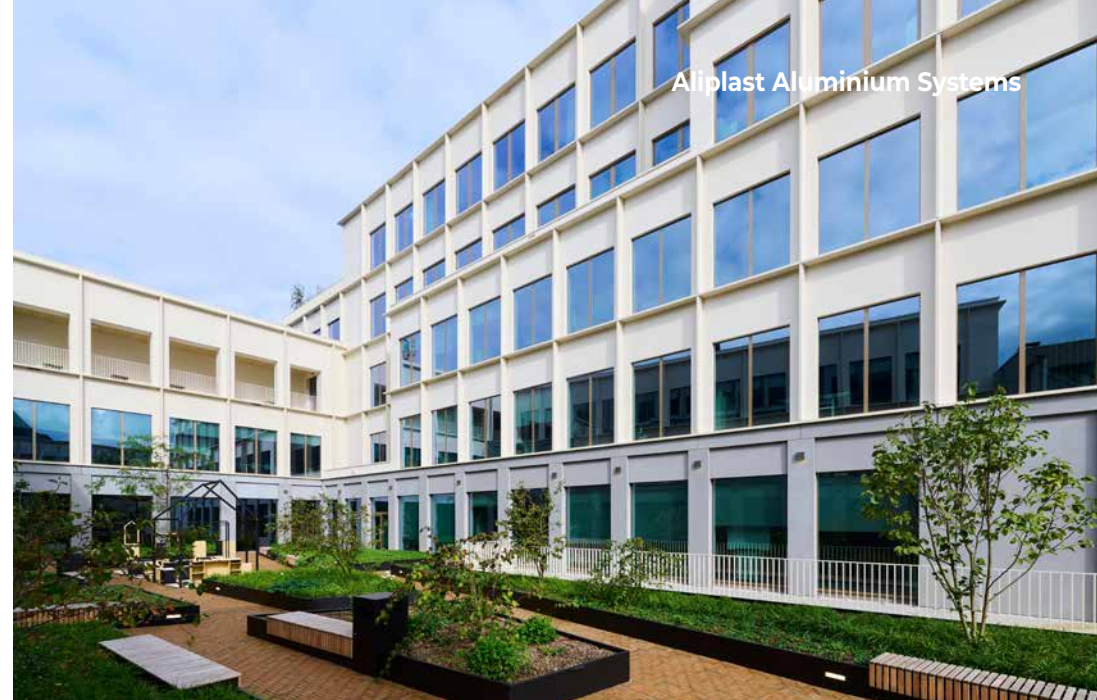
Op vraag van Algemene Bouw Maes dokterde Aliplast samen met installateur Luckx een maatoplossing uit voor de beoogde gevelgeleding.
