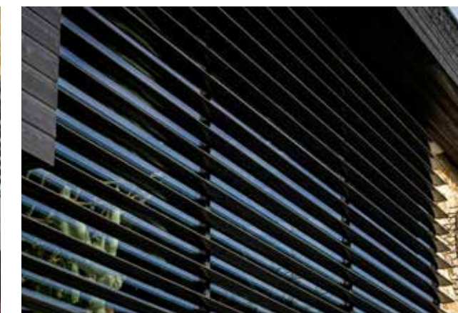
De Star 75 ramen en de MC Wall vliesgevel en zonwering werden gerealiseerd in de kleur RAL 7022 (ombergrijs), een warme grijze tint van de klassieke antracietkleur.
